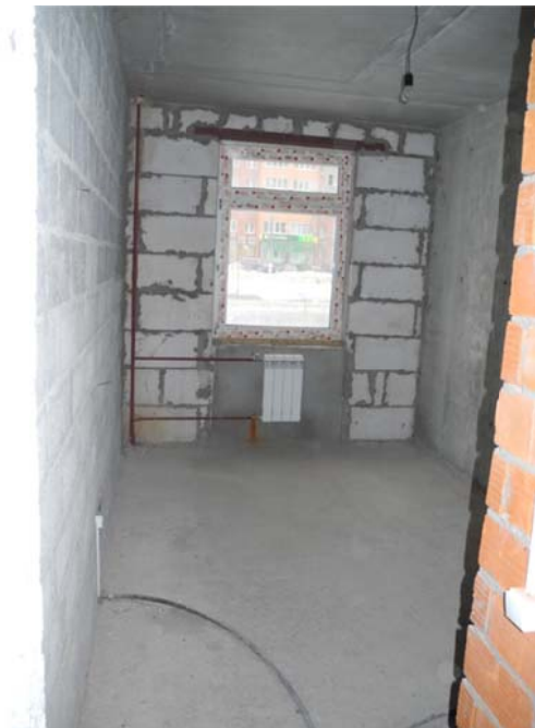
фото.1 - фасадная стена с заполнением из ячеистых блоков в месте устройства входа №1
