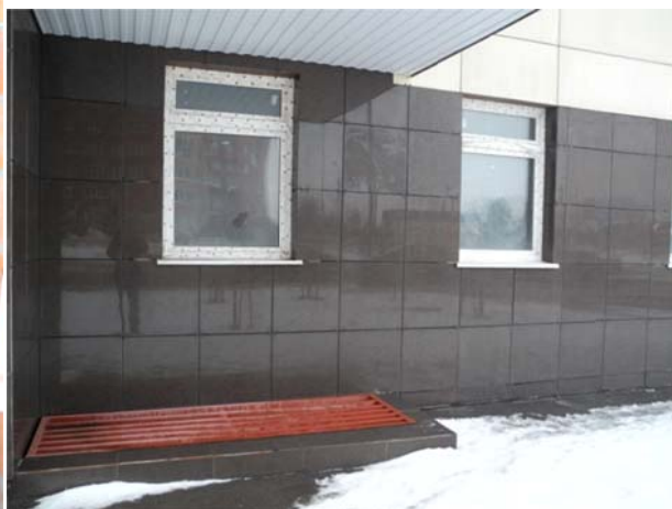
фото.2 - фасадная стена с навесным фасадом из керамогранита в месте устройства входа №1
