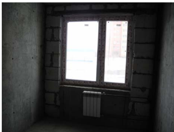
фото.3 - фасадная стена с заполнением из ячеистых блоков в месте устройства входа №2
