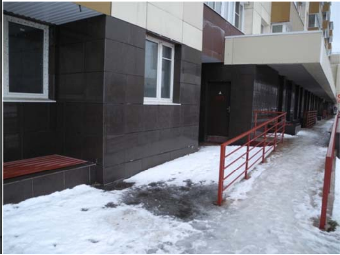
фото.6 - фасадная стена с навесным фасадом из керамогранита в месте устройства входа №3
