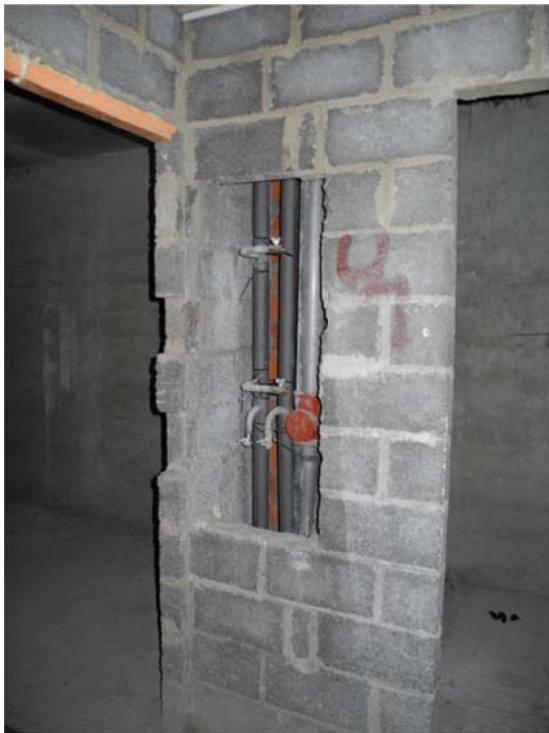
фото.7 - шахта инженерных коммуникаций
