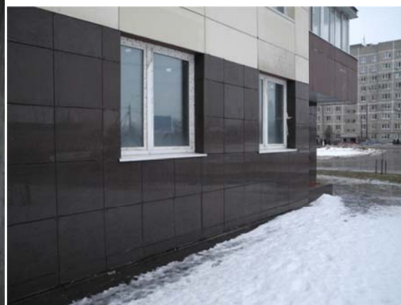
фото.4 - фасадная стена с навесным фасадом из керамогранита в месте устройства входа №2
