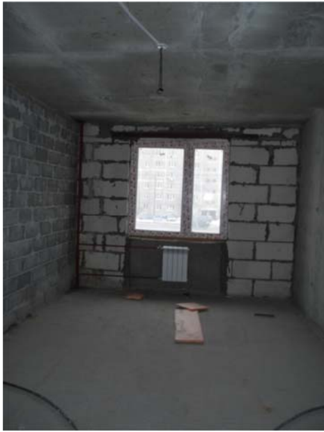
фото.5 - фасадная стена с заполнением из ячеистых блоков в месте устройства входа №3
